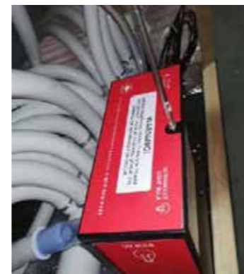
8. Schritt: Rote Abdeckung wieder festschrauben
