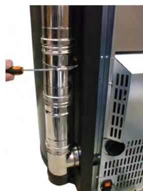
Fig. 83 - Rauchgaskanals (Sfera<sup>3</sup> Plus, Sfera<sup>3</sup>, Globe, Elise<sup>3</sup> Plus)
