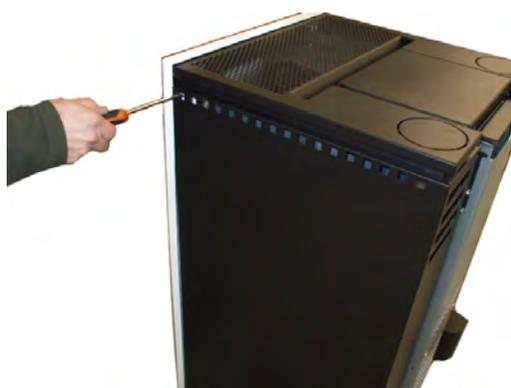
Fig. 61 - Lösen der oberen Schraube
