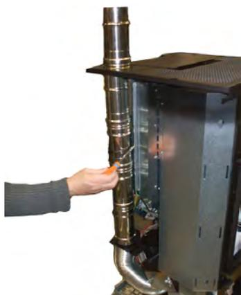
Fig. 45 - Positionierung der Rohre für oberen Kanal
