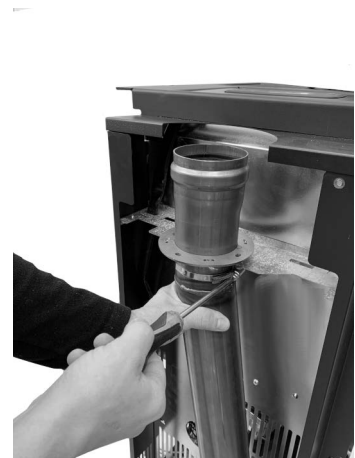
Fig. 42 - Mit Schelle sichern
