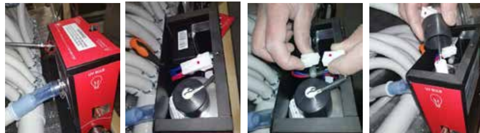
1. Schritt: Unscrew the 2 red-marked screws. 2. Schritt: Die rote Abdeckung abnehmen 3. Schritt: Weiße Verbindungsstücke entkuppeln 4. Schritt: Schwarze Abdeckung herausnehmen
