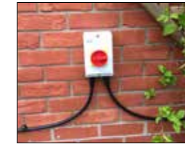
Dreh-Trennschalter (abgebildet). Stellen Sie sicher, dass Sie die Höhe und Breite Ihres Whirlpools und fügen Sie auf jeder Seite 5 cm Freiraum hinzu, um den Zugang zu gewährleisten.
