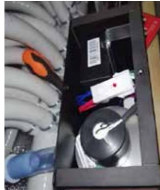
2. Schritt: Die rote Abdeckung abnehmen
