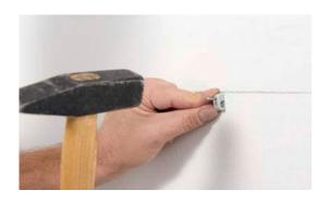
• Auf die untere Verlegelinie Nägel einschlagen ggf. Holzleiste oder Nagelschellen verwenden.
