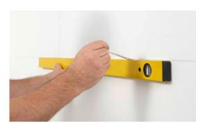
• Untere Verlegelinie mit Wasserwaage ausrichten.
