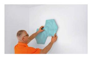
• ARSTYL® WALL TILES Stoß an Stoß montieren
