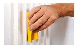
Nach Trocknung (ca. 6 Std.) Stöße leicht anschleifen (Schleifpapier Körnung 150 oder feiner) und mit Spachtelkleber ADEFIX® nachspachteln.
