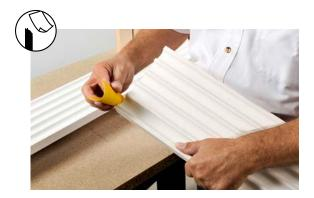
• Schnittkanten mit Schleifpapier leicht brechen und vom Sägemehl befreien.
