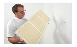
• Die auf der Rückseite der Paneele aufgebrachte Richtungspfeile beachten, sie müssen in die gleiche Richtung zeigen.
