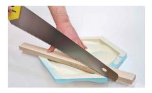
• ARSTYL® WALL TILES mit Hilfe von Handsäge und Vierkantholz zuschneiden.
