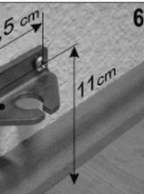
Den unteren Halter (C) mit einer Wasserwaage ausrichten und festschrauben!
