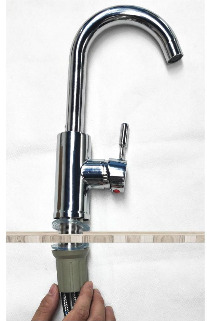
3. das andere Ende der Kalt- und Warmwasserleitung durch einen wasserdichten Dichtungsring und eine Sicherungsmutter geführt, gedreht und festgezogen wird
