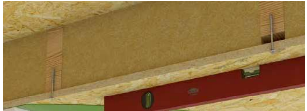
Distanzschraube mit Senkkopf und Innensechskant zum Ausgleich von Baulatten.
