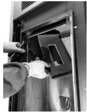
Fig. 78 - Die Stirnseite des Feuerraums 2 entfernen
