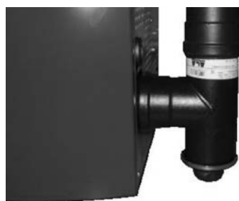
Fig. 75 - Reinigung des Rauchgaskanals
