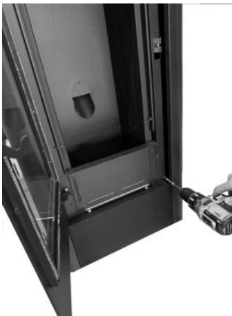
Fig. 38 - Schrauben entfernen
