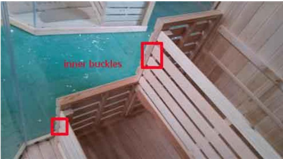
Befestigen Sie die linke Seite der Frontplatten mit Innenwölbung, und die rechte Seite der Frontplatten mit Schrauben an der großen Frontplatte der rechten Bank.
