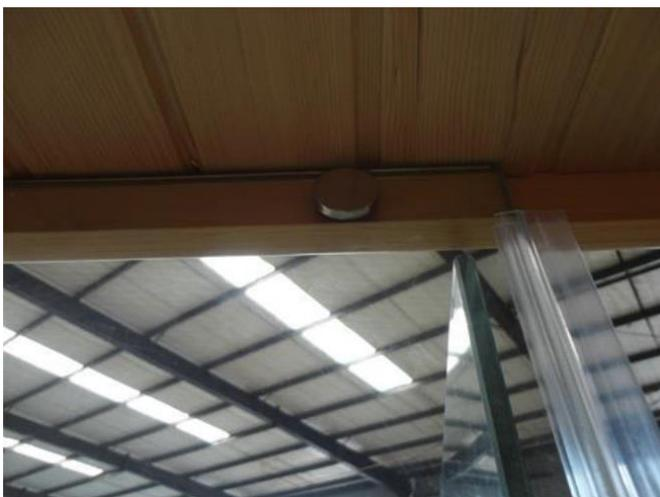
Hinweis: Setzen Sie die Kunststoffdichtungen zwischen die Glasscheiben, achten Sie darauf, dass keine Lücken entstehen. Dies ist wichtig, damit keine Hitze entweichen kann.
