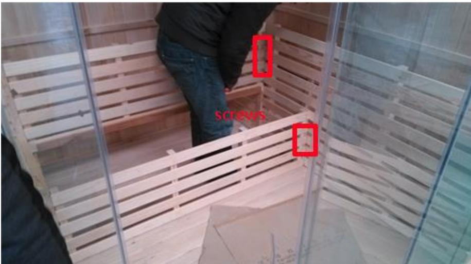
Legen Sie die Deckplatten der Sitzfläche an die Stützplatten.
