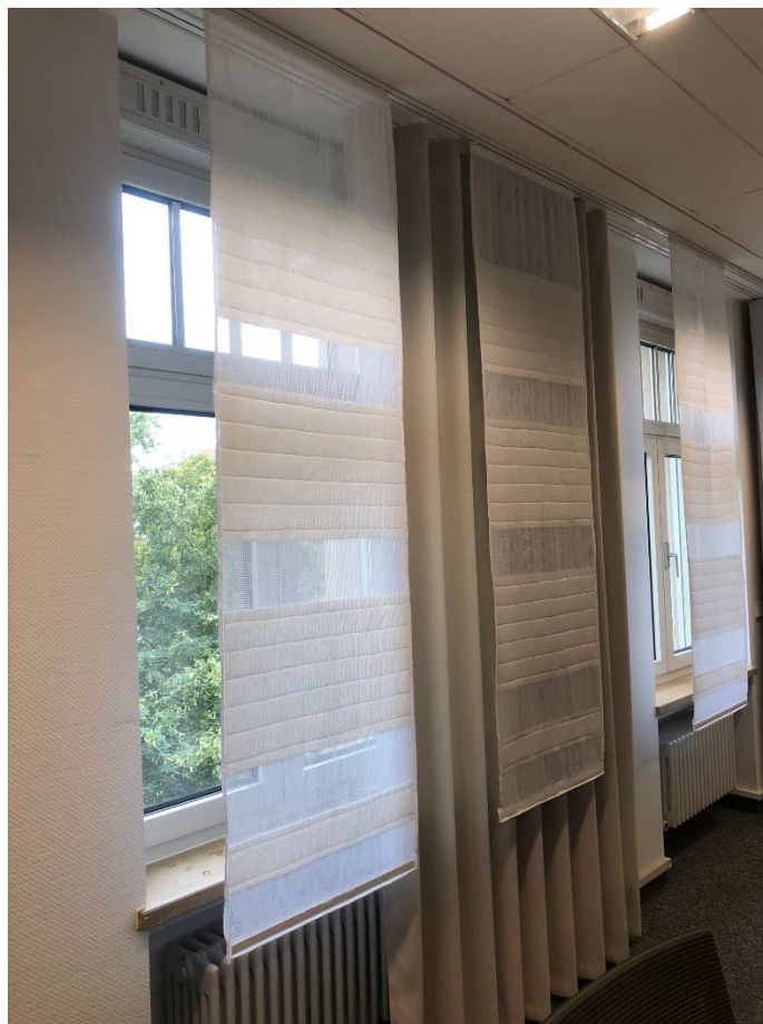
Foto: Einsatz der kühlenden Vorhänge in Bürogebäuden
