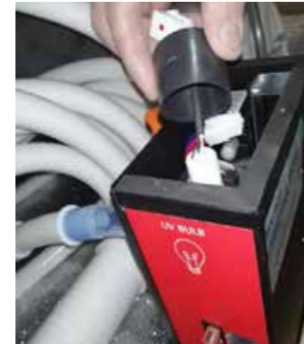
4. Schritt: Schwarze Abdeckung herausnehmen
