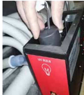
6. Schritt: Neues UV Licht in die Metallröhre stecken und schwarze Abdeckung wieder darauf stecken
