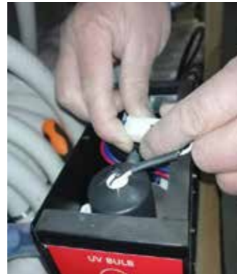
7. Schritt: Weisse Verbindungsstücke wiederverkuppeln
