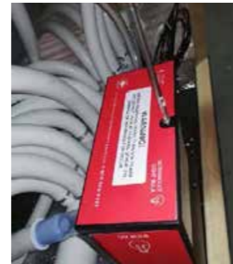
8. Schritt: Rote Abdeckung wieder festschrauben
