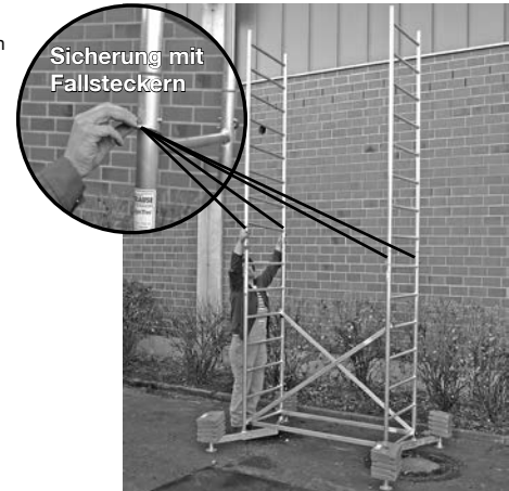
Grundgerüst mit erster und zweiter Aufstockung
