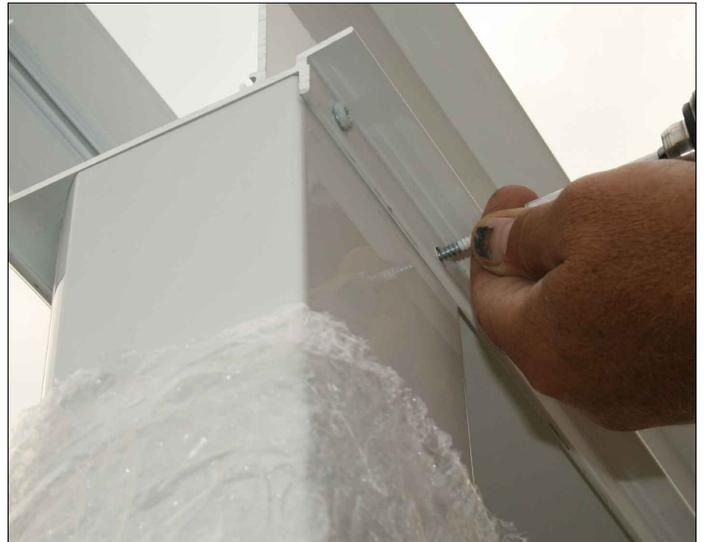
Legen Sie die Rinne und die Pfosten entsprechend aneinander, bohren Sie mit einem Metallbohrer 4mm vor und verschrauben Sie dann die Bauteile mit jeweils 2 Karoserieschrauben (C101-025).
