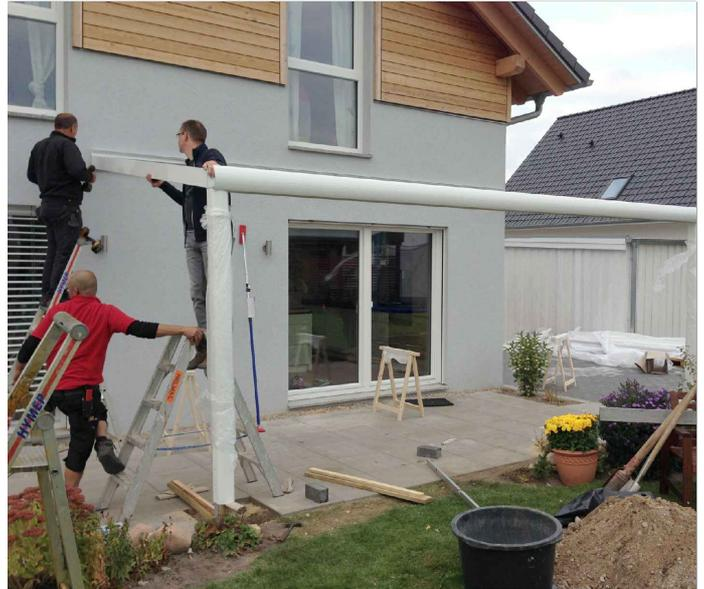
Legen Sie die beiden äußeren Sparren ein und richten Sie diese an der Wand- und an der Rinnenpfette aus.
