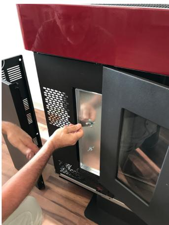
Fig. 74 - Das Wärmeschildpaneel entfernen
