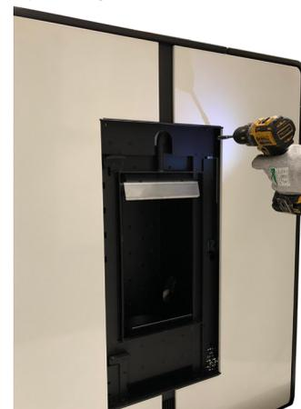
Fig. 40 - Befestigen der Verkleidung
