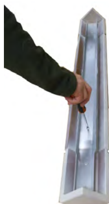
Fig. 26 - Das Profil an den Majoliken anschrauben
