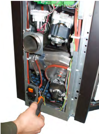
Fig. 84 - Reinigung Rauchgasansauggerät: Phase 1
