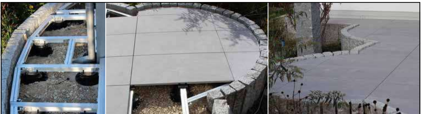
Anwendungsbeispiel: Erhöhte Fläche (Aufbau) mit Terrassenfliesen und dekorativer Granitsteineinfassung.
