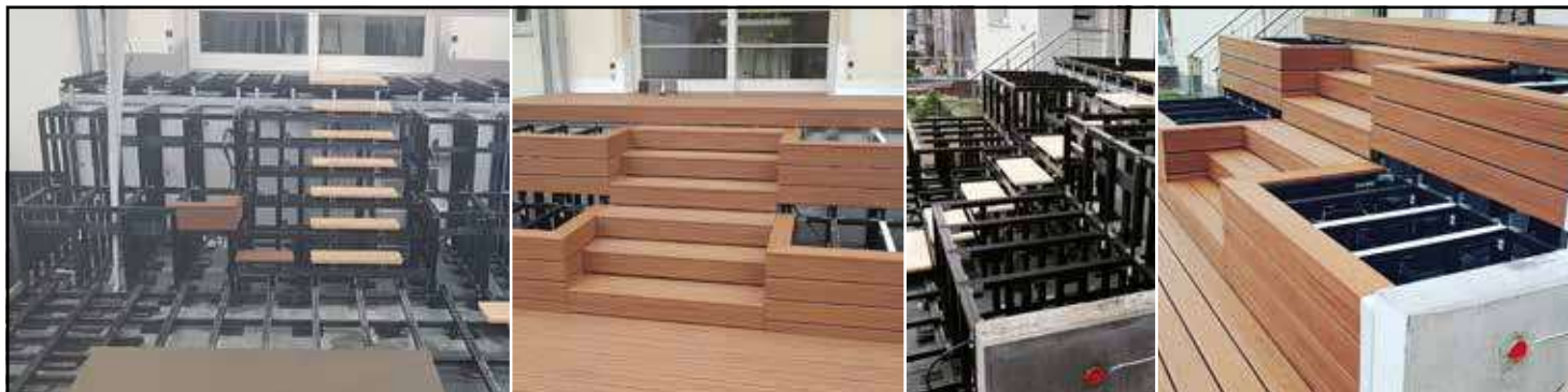
Stufenausbildung Kombination Unterkonstruktions- und Konstruktionsprofil
