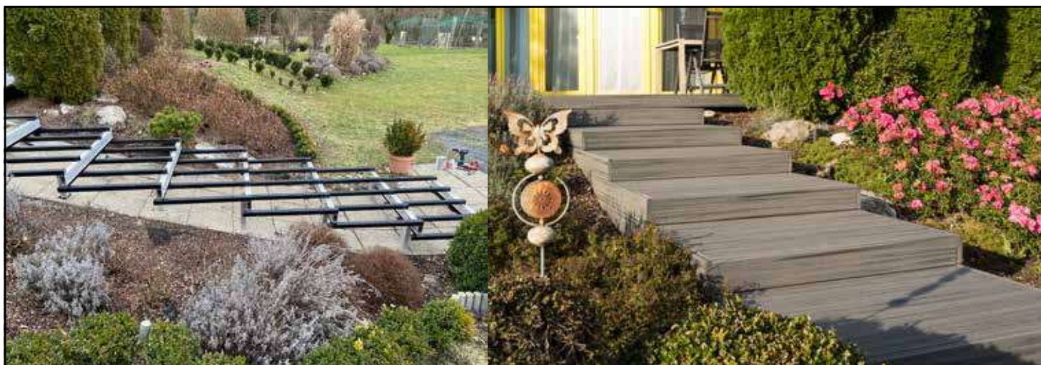
Treppenausführung mit U 38/45 mm und U 85/45 mm
