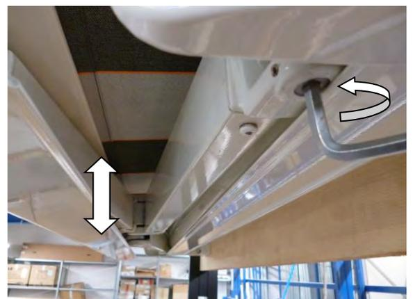
**Achtung: Wir weisen an dieser Stelle daraufhin, dass die Gelenkarme im Werk voreingestellt werden. Jedoch kann es aufgrund der Montage vor Ort zu Abweichungen kommen. Diese können sich unter Umständen durch ein „Schleifen“ der Gelenkarme im Gehäuse bemerkbar machen. Diese Korrektur obliegt dem Monteur bzw. dem Kunden und kann nach oben genannter Vorgehensweise, simpel nachjustiert werden**
