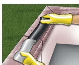
4. Retire (en uno o ambos lados dependiendo de la variante) si existe la lámina protectora. Seguidamente, coloque la cinta con el lado adhesivo hacia abajo en la zona a adherir.
