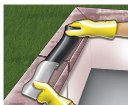
4. Schutzfolie abziehen (ein oder beidseitig je nach Variante) sofern vorhanden. Legen Sie danach das Band mit der klebenden Seite nach unten auf die zu klebende Stelle.
