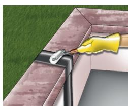
5. Druk de tape aan met een roller of iets dergelijks. Zorg ervoor dat de tape stevig aan het oppervlak is aangedrukt.
