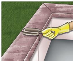
1. Reinig het oppervlak waarop de tape wordt aangebracht. Om optimale hechting te bereiken, moeten de oppervlakken zo droog en schoon mogelijk zijn.
