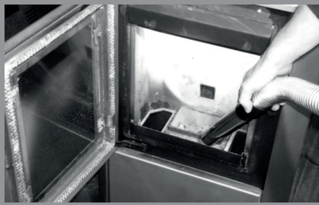
Abb. 12a: Reinigung des Brenntopfes
