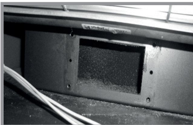
Abb. 13c: Aussaugen der Frontplatte
