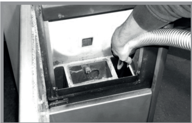
Abb. 12g: Reinigung untere Brennkammer
