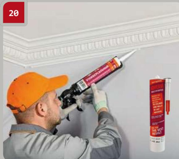
Mit G10U290 die Zwischenräume im Fugenbereich zwischen Gesims und Wänden/Decke ausfüllen, wo der Kleber nicht aus der Fuge ausgetreten ist.
