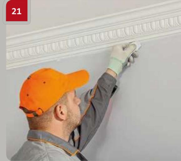
Überschüssigen Kleber mit einem mit Aceton benetzten Tuch entfernen.
