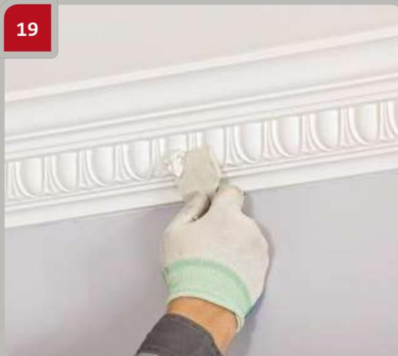
Füllen Sie die behandelte Fläche mit einer feinkörnigen, wasserlöslichen Spachtelmasse für den Innenausbau und wiederholen Sie ggf. Schritt 18, bis eine ebene Oberfläche entsteht.
