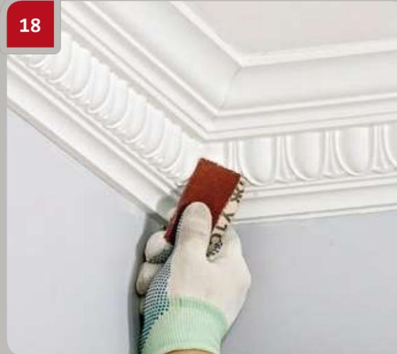
Nach 3 Stunden die Fugen mit feinkörnigem Schleifpapier schleifen.
