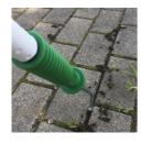
Moose sind ohne Probleme mit dem Gigant zu entfernen. Hartnäckige Unkräuter erfordern mehr Kraft, die Sie am besten mit dem Gigant ohne Stiel entfernen Nach dem Fugenreinigen mit dem Gigant am besten Bau- oder Quarzsand einfegen.
