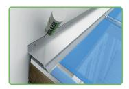
Anschließend dichten Sie die Wandfuge mit guttagliss Silikon
