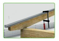
Verschrauben Sie nun die Profile mit Edelstahlschrauben für Holz 4.5 mal 35 mm durch die vorgebohrten Löcher.
