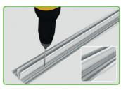
Setzen Sie nun die nötigen Bohrlöcher mit Durchmesser 5 mm. Die erste Bohrung 8 cm von der Vorderkante, dann alle ca. 35 cm bis zum Ende, abwechselnd links und rechts vom Mittelsteg in der Bohrnut.
